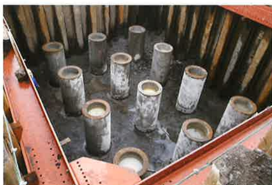
施工後の杭頭部掘削状況
