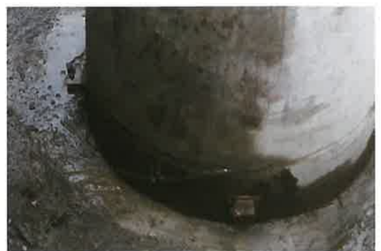
施工後の杭頭部掘削状況
