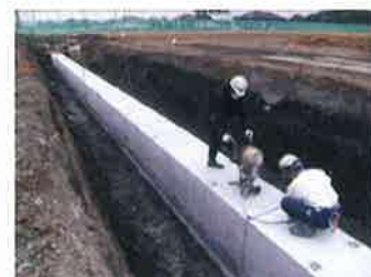
長尺PRC 600×600×4000 長尺ボックスカルバートへの適用例
