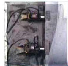
ソケット バックアップ材 (内側) 高弾性接着剤 15
