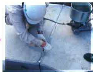
上部より頂版天端部へ注入
