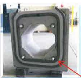
供試体の断面 (写真は注入工法) 高弾性接着剤 (TBボンド)
