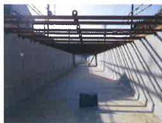
U型4700×2400×1200mm 開水路への適用例（コーキング工法）
