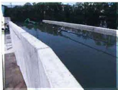
変位後の漏水なし
