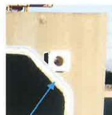
充填後 高弾性接着剤の充填部 (内目地)
