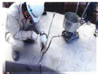
注入口より側壁部・底版部へ注入
