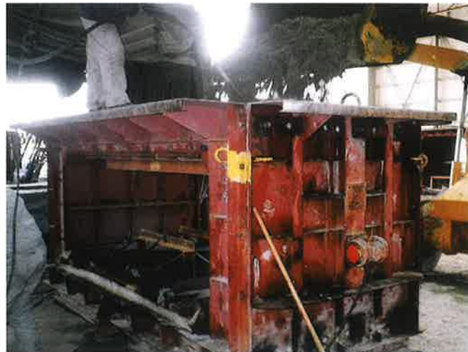
コンクリート打込み
