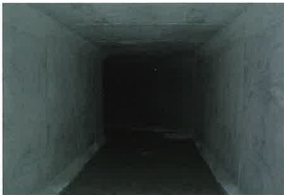
(※5) 千葉県八千代市 BOX 2300×2300×1500mm 他 (TB工法)
