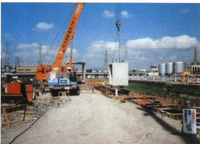
搬入及び施工
