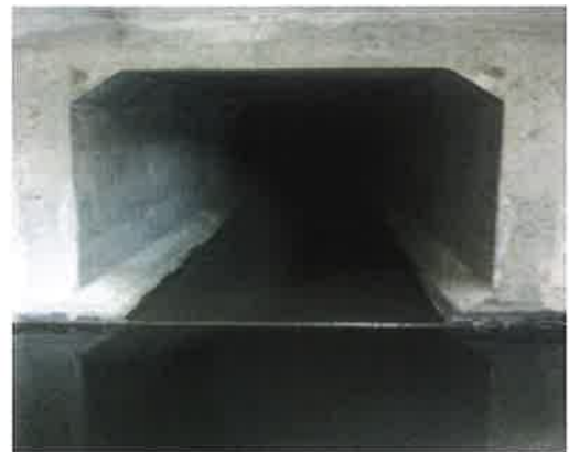
(※6) 茨城県石岡市 BOX 800×800×2000mm (TB工法)
