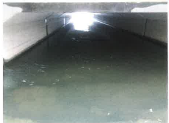
(※4) 茨城県鉾田市 BOX 1500×1500×2000mm (TB工法)
