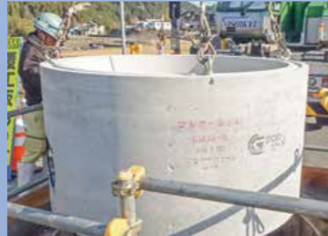
組立マンホール
