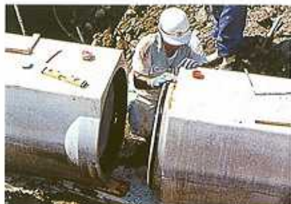
注) レバーブロックはφ800以上のサイズに使用します。
