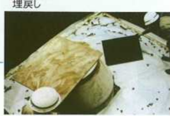
5. 上部砕石シート元素の敷設及び埋戻し
