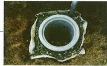
5. 上部シート元素の敷設及び埋戻し
