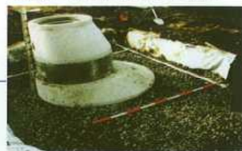
5. 上部砕石シート元素の敷設及び埋戻し
