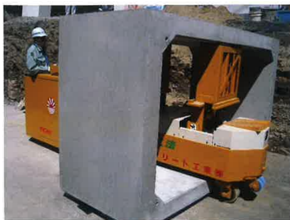
【ECO-C・L工法による搬送・据付】
