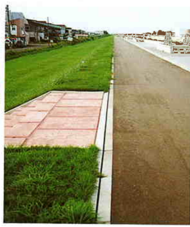
●北海道/石狩川開発建設部 月寒川築堤
