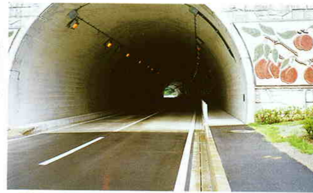
●鹿児島県/大島支庁 尾神山トンネル
