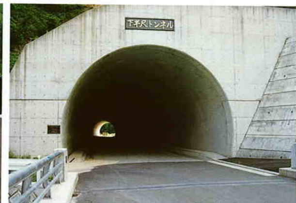
●熊本県/建設省竜門ダム工事事務所 下半尺トンネル新築工事
