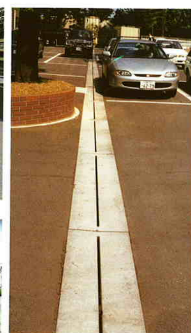
●埼玉県/民間 M建設本社外構工事
