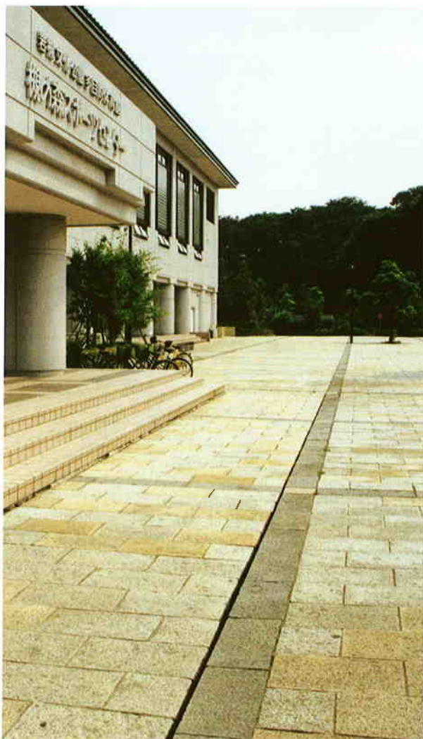
●埼玉県/岩槻市 観の森スポーツセンター新築工事
