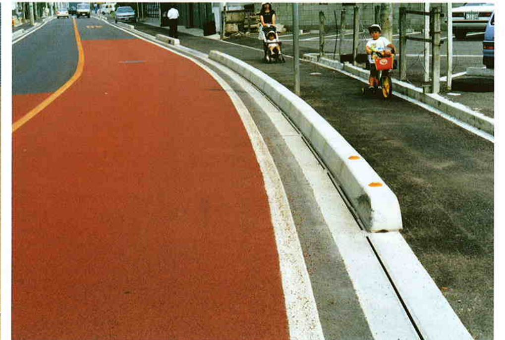
●千葉県/柏市 常盤台道路改良工事
