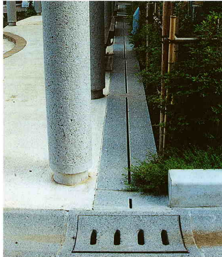
●埼玉県/庄和町 町営住宅外構〈小たたき〉
