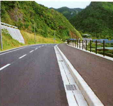
●鹿児島県/大島支庁 名瀬市有良地内
