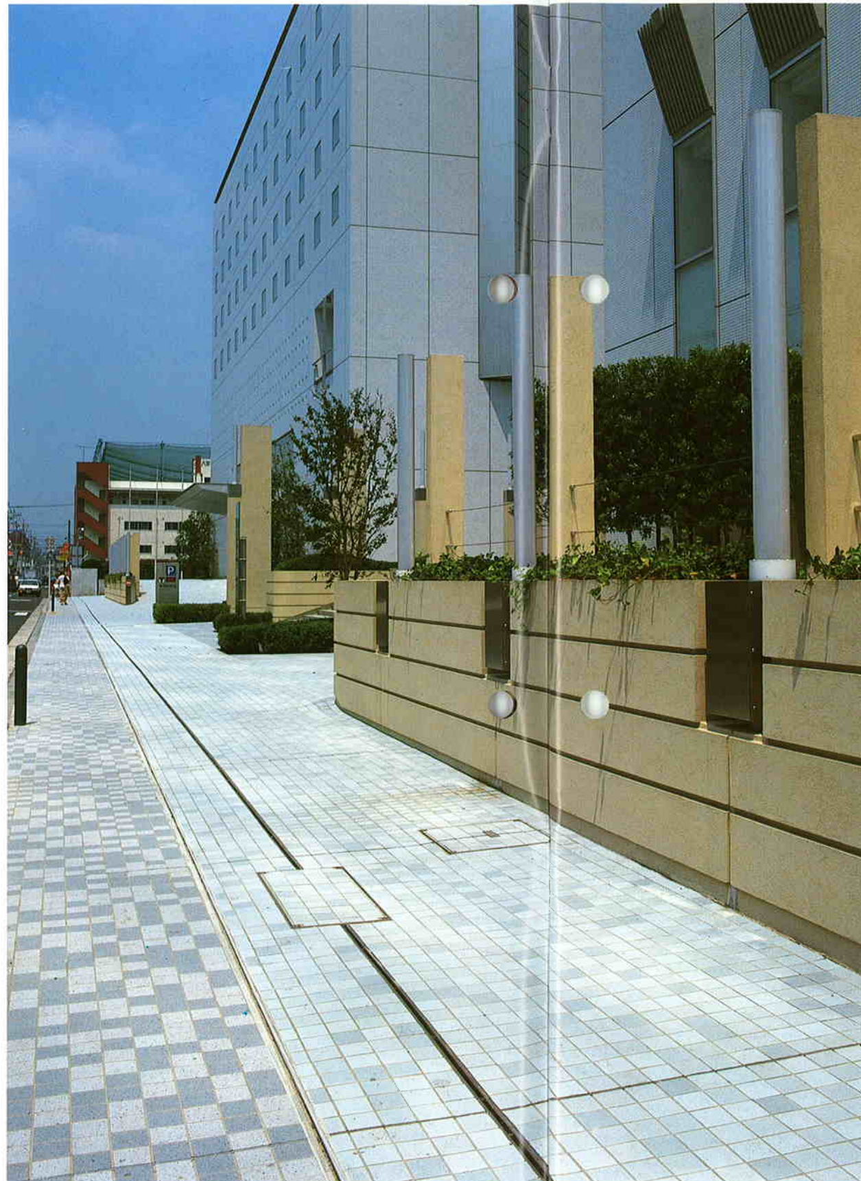
●神奈川県/海老名市 第一生命ビル外構工事
