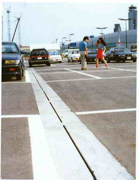
●千葉県/新東京国際空港公団 空港ターミナル
