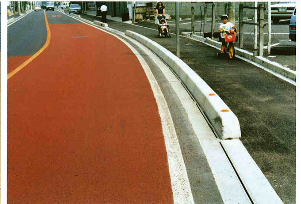
●千葉県/柏市 常盤台道路改良工事
