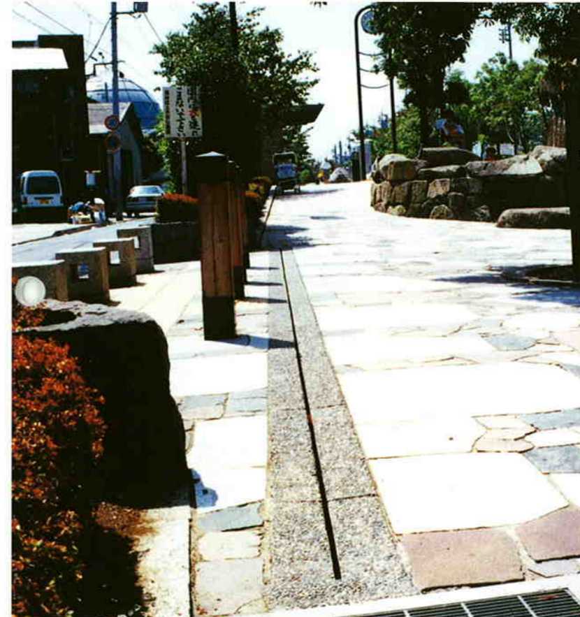
●東京都/葛飾区土木部 曳舟親水公園〈洗いだし〉
