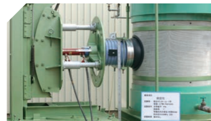
変位量(屈曲角1°かつ外側60mm)に移動し、内水圧0.05MPaを保持する。
