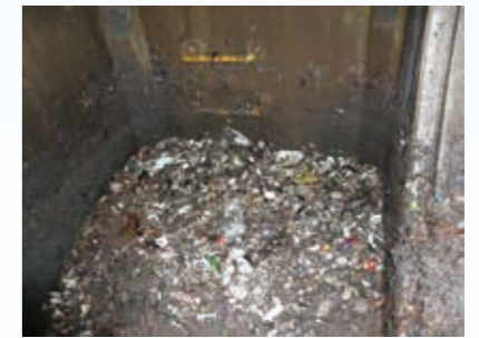
●雨水貯留浸透施設
